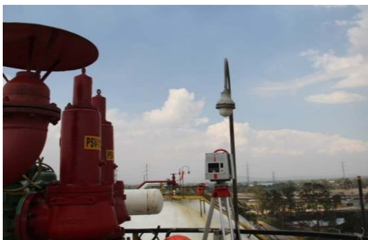
ESCANEEO DE INSTALACIONES
